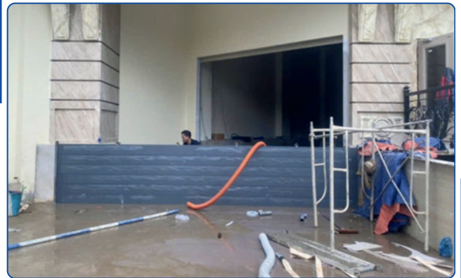
Chống ngập tầng hầm Tòa nhà Vietravel Chi nhánh Huế
